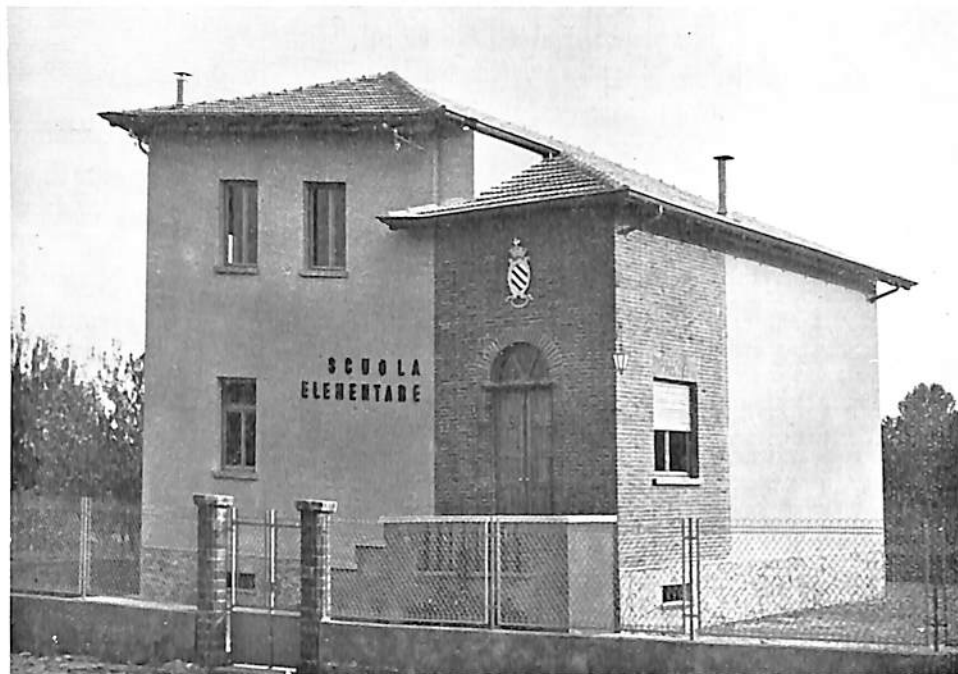
Nuovo edificio Scuole Elementari in Frazione S. Anna
