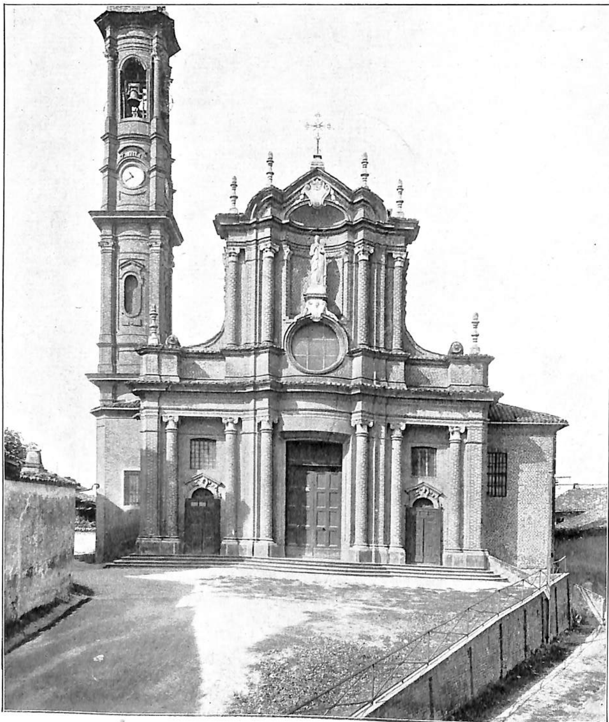
Facciata della parrocchia di Cambiano (1740-41).
