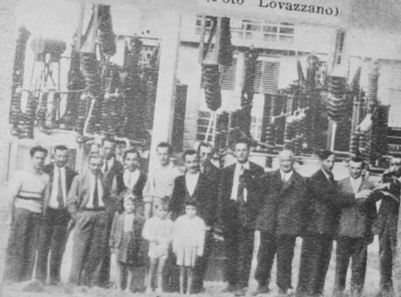
PONT CANAVESE - Maestranze della Centrale elettrica Città di Torino A.E.M.
